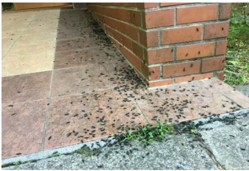
4棟 エン ト ラ ン ス
