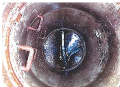
綺麗になった桝内部
