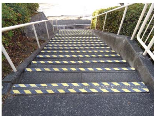
20棟北側通路階段部 滑り止めテープ試験施工
