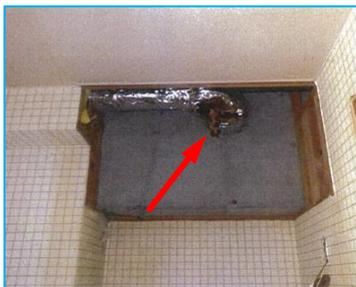
写真1 通気管腐食
