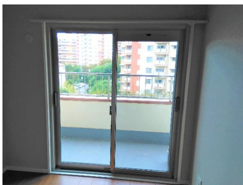
写真3 アルミサッシ更新後
