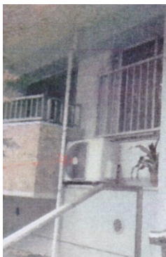
1階梁の上への室外機の設置（例）
